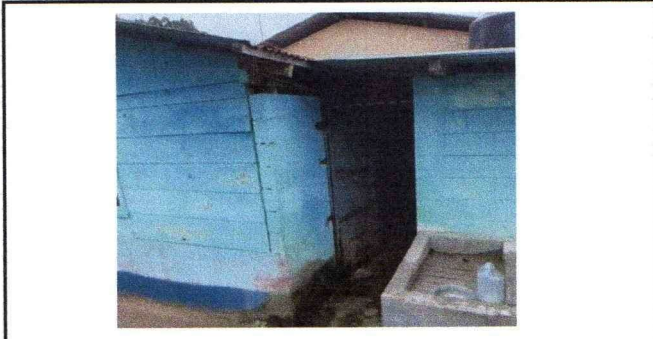
Foto 4: Mantenimiento de estructura de puerta de metal
