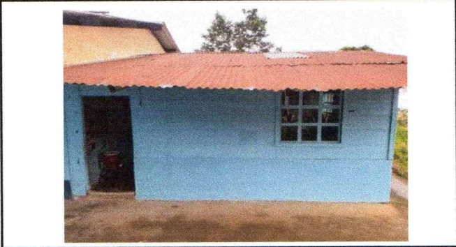
Foto 2: Sustitucion de lamina por lamina troquelada aluzinc
