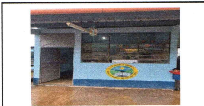
Foto 6: Sustitucion de lamparas
