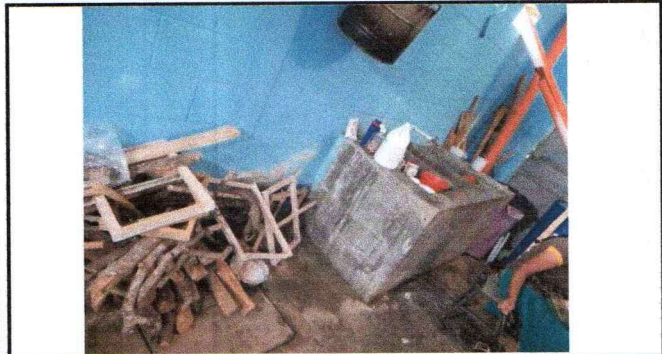
Foto1: Reconstruccion de pila con azulejo
